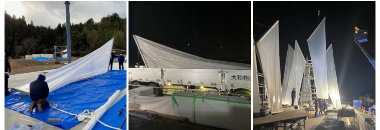
空気膜ユニットの工場地組・現場搬入・現場施工の様子
