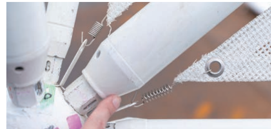
KUMIKO ファサードの膜留め付け金物部分
