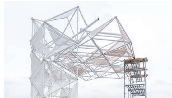
KUMIKO ファサード× TM トラスの接合部
