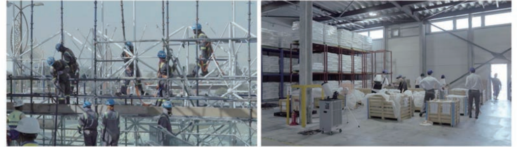
ドバイでの解体様子
