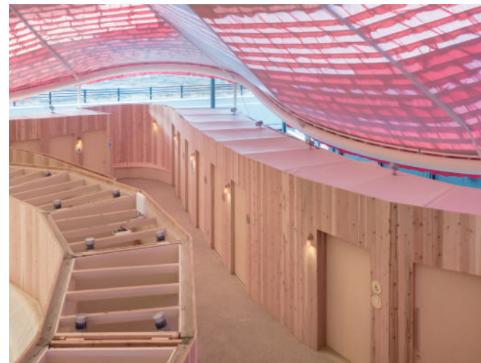
トイレブースの天井にはターボスクリーンを用いている。
