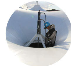
9 引き込み部張力導入
