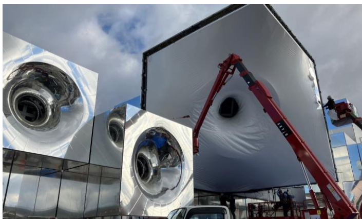
膜建方時 現場写真-2
