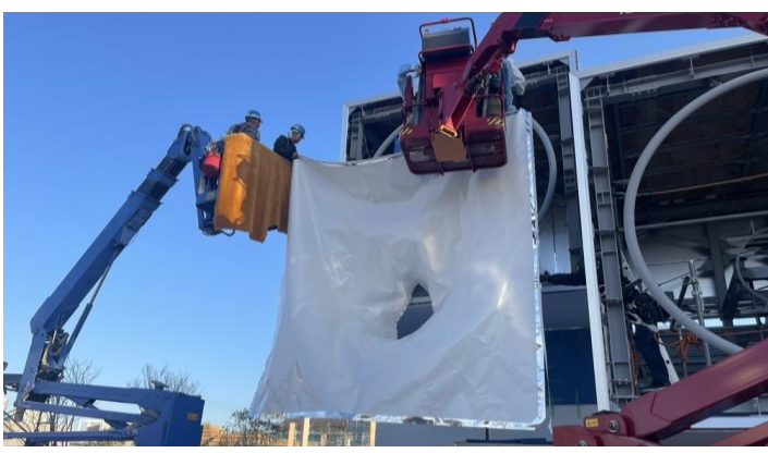
膜建方時 現場写真-1
