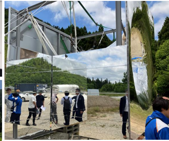
膜モックアップによる製作・施工方法・皺検証
