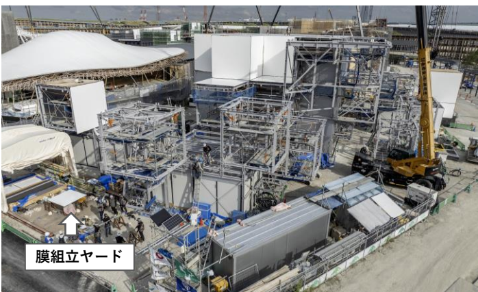
鉄骨建方時 現場写真
