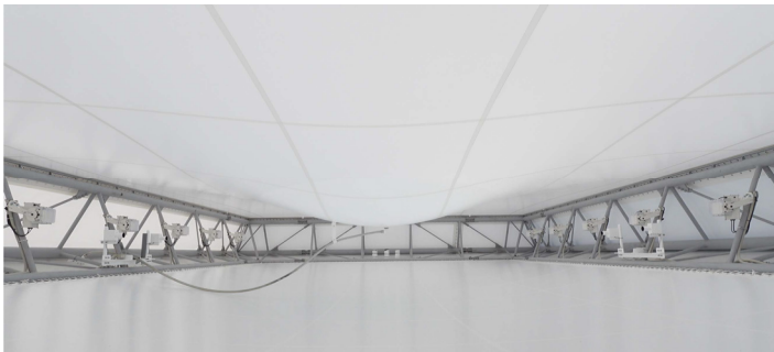
2.膜屋根内部 (水溜時)
