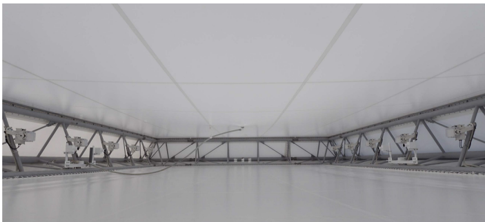
0.膜屋根内部 (常圧時)
