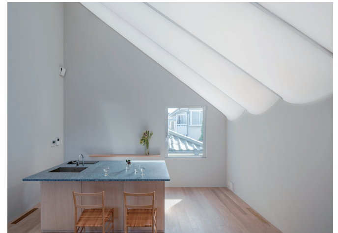
2階は開口部の面積をできるだけ絞り、膜の効果を最大限生かす計画としている。
