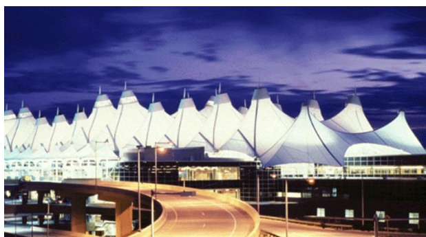
図1 空港屋根の事例
