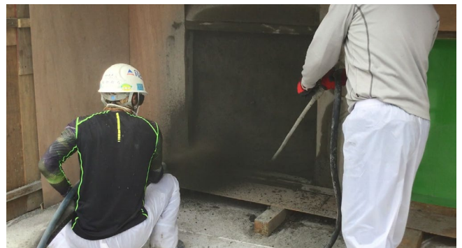
吹付けコンクリート施工試験
