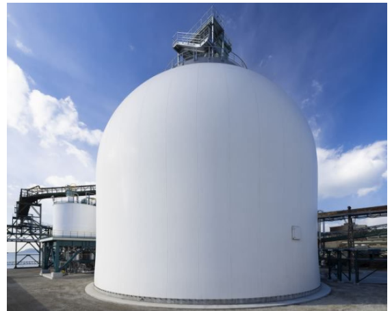
トクヤマドーム (貯蔵施設)
