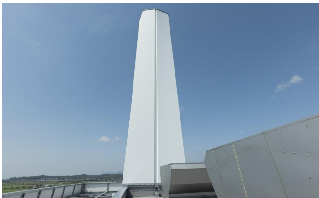
図一 9 次世代煙突 施工写真
