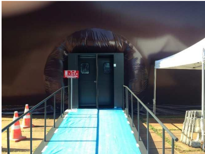
メイン出入口（回転扉2ヶ所）
