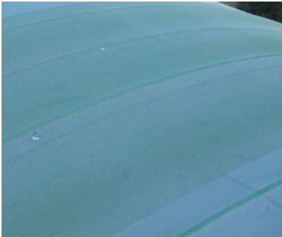
写真-1：テント倉庫外観
