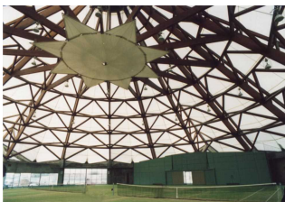
富山ドーム 積雪荷重 450kg/m 2 の多雪区域 木造架構と膜面：屋根勾配 40° で積雪のない屋根としている。
