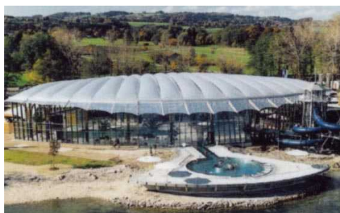
写真5 キーム湖屋内プール
