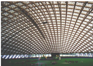
大館樹海ドームパーク 木造と膜面（現地杉集成木材） 荷重積雪 450kg/m 2 の多雪区域 での集成木材ドーム架構
