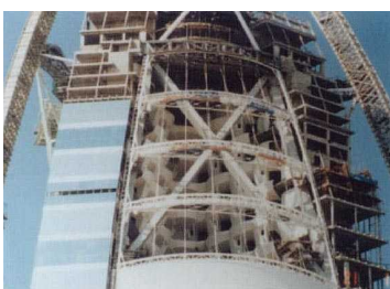
写真2 ドバイホテルの膜の施工中
