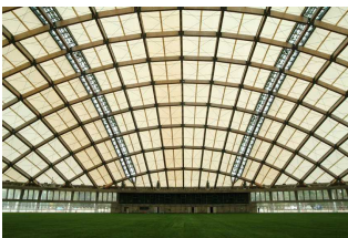
木の花ドーム 積雪のない地方での集成木材 ドーム架構と膜面
