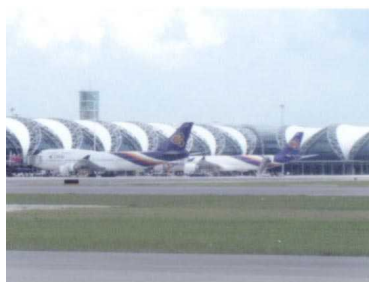
写真 23 バンコック第二空港 コンコース外観
