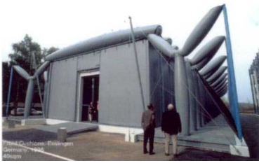
写真 13 エアーチューブによるラーメン構造の例
