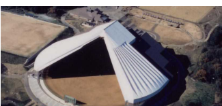
富山ドーム 積雪荷重 450kg/m 2 の多雪区域 木造架構と膜面：屋根勾配 40° で積雪のない屋根としている。
