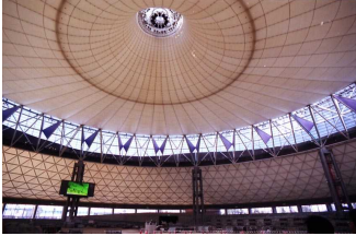
パークドーム熊本 ケーブル補強二重空気膜構造
