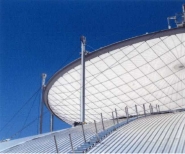
写真 9 マドリッド闘牛場屋根
