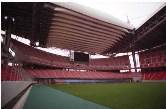
トヨタスタジアム： 空気膜構造面折りたたみによる 屋根の開閉
