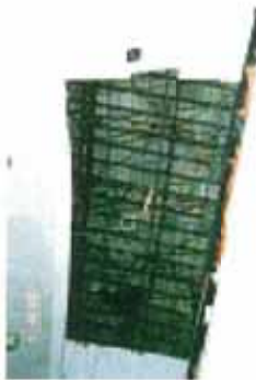
(a)新潟県中越地震後の公共ホール(吊り天井の脱落)
