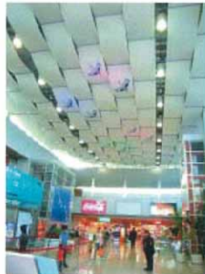
図7:釧路空港の復旧(膜材による天井の張替え)
