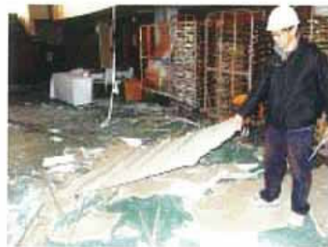
(a)新潟県中越地震後の公共ホール(吊り天井の脱落)
