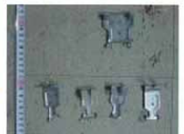
(i)変形脱落したフック金物
