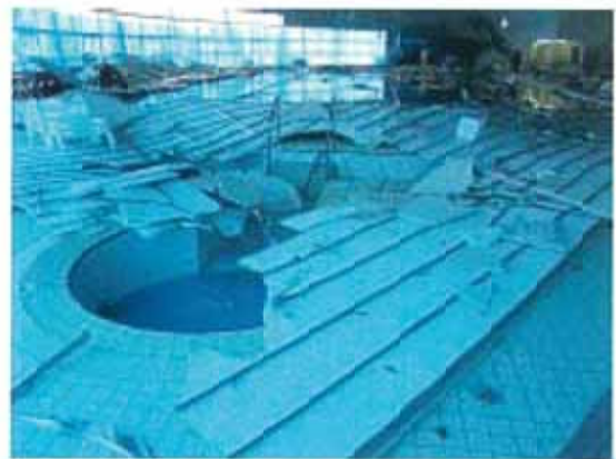
(b)野縁(金属製下地材)ごと落ちた天井材
