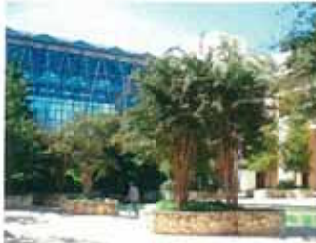
サンアントニオ コンベンションセンター
