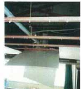
(f)ビスの頭抜けによる天井材脱落
