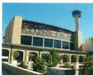
サンアントニオ コンベンションセンター
