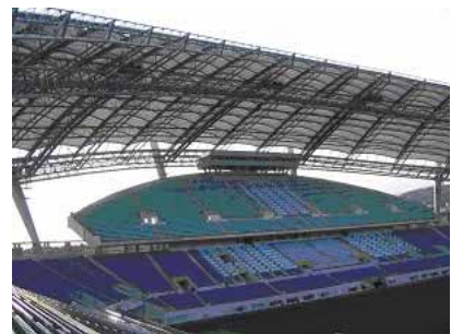
Fig. 20 : 競技場屋根膜の上部
