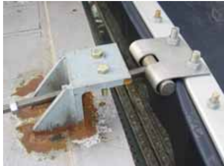
Fig. 16 : Arch purlin の溶接部詳細
