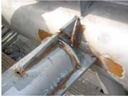
Fig. 16 : Arch purlin の溶接部詳細
