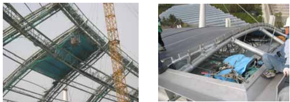
Fig. 15 : Mock-up Test 現場
