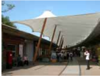
ビジターセンターの膜屋根
