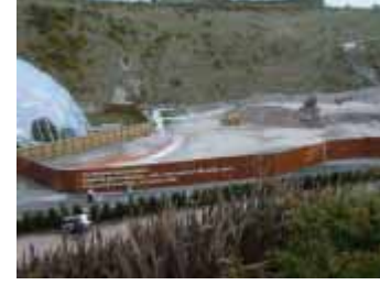
教育資源センター工事の様子
