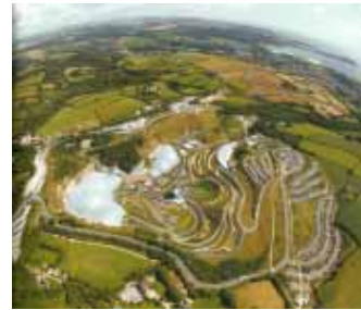
敷地全体の様子
