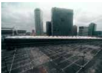
フィルム屋根の外観
