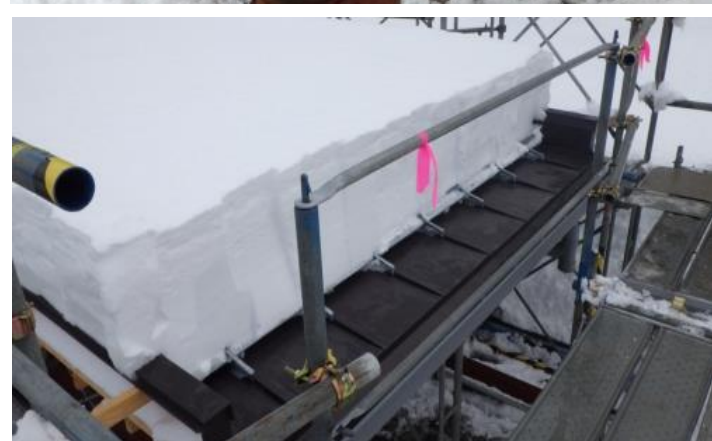
屋根端部状況
