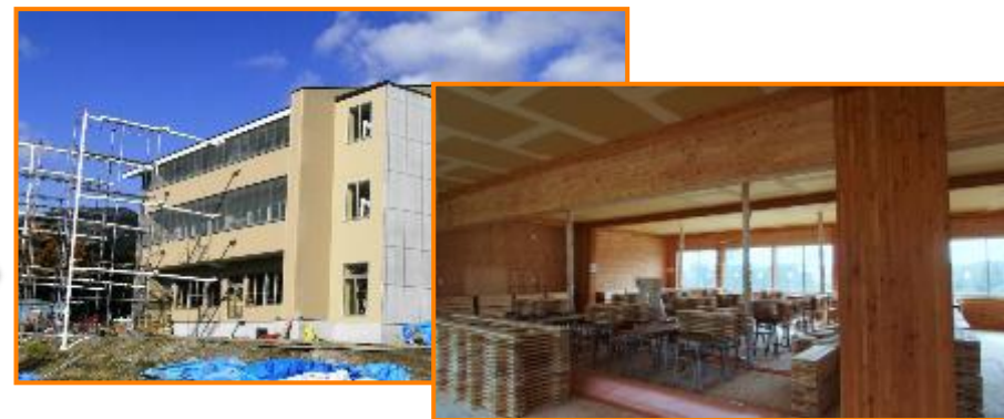
木造の3階建て学校＜実大火災実験の試験体＞
