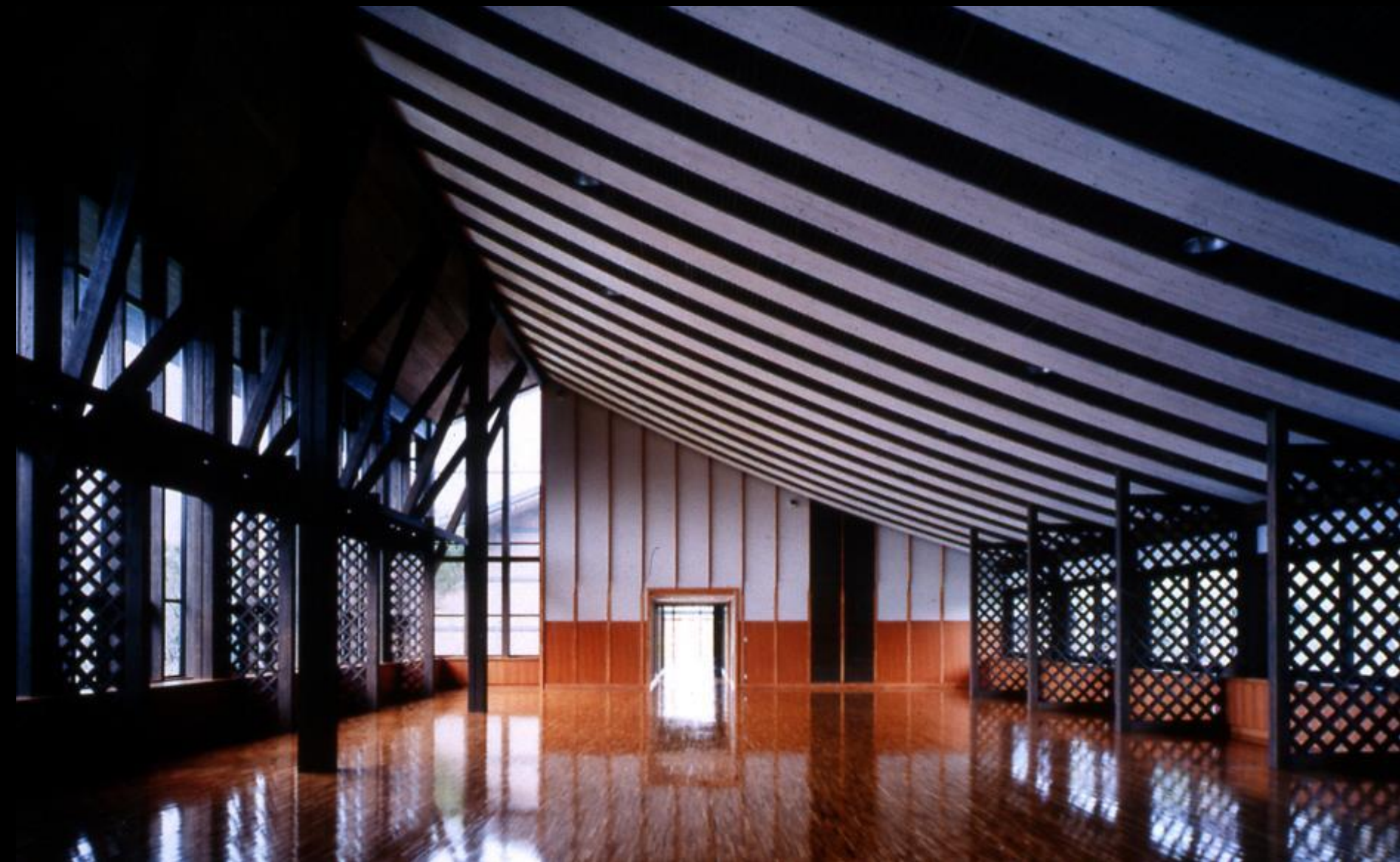
展示棟内部 大きな梁架構と格子耐力壁
