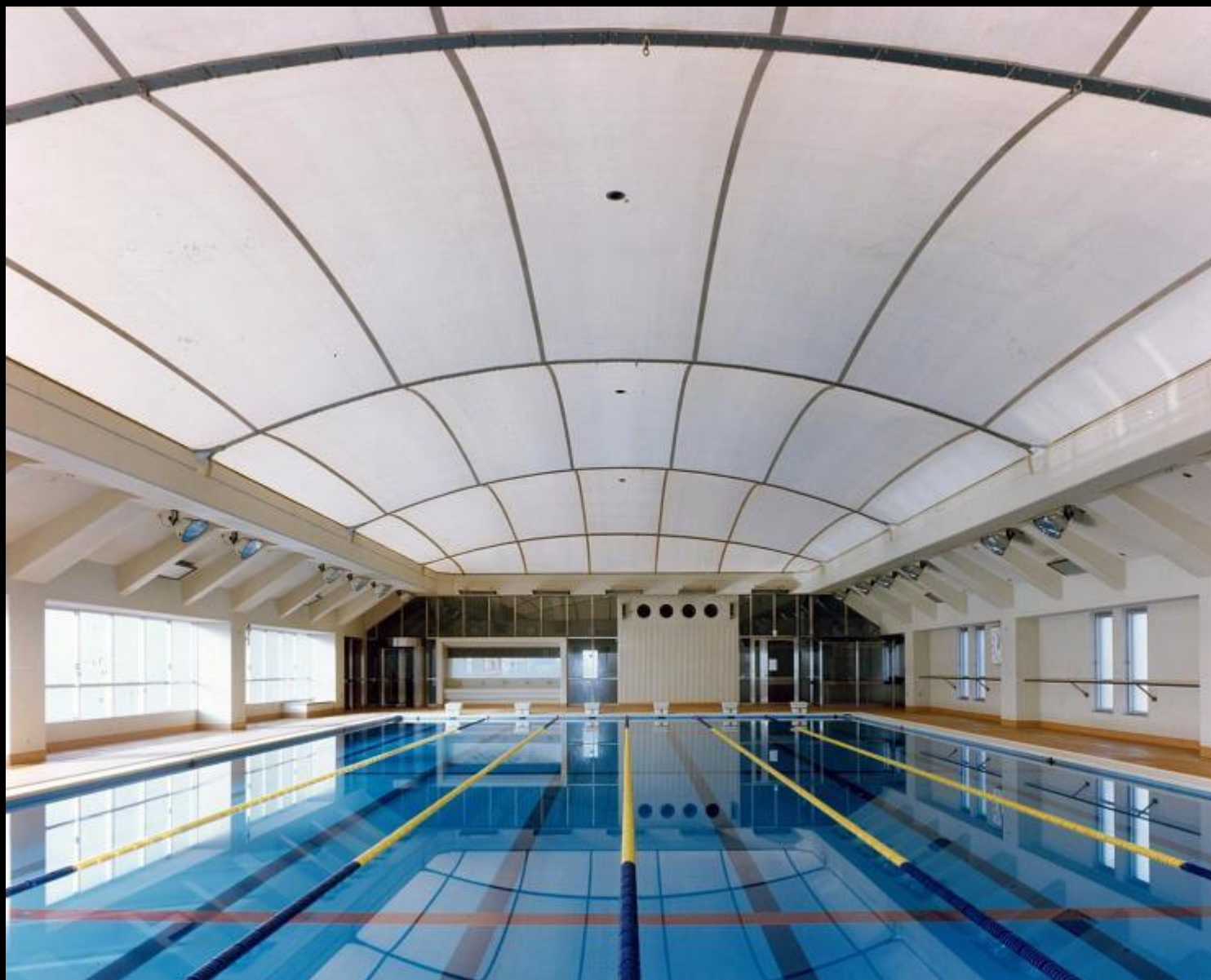
プール室 北向き
