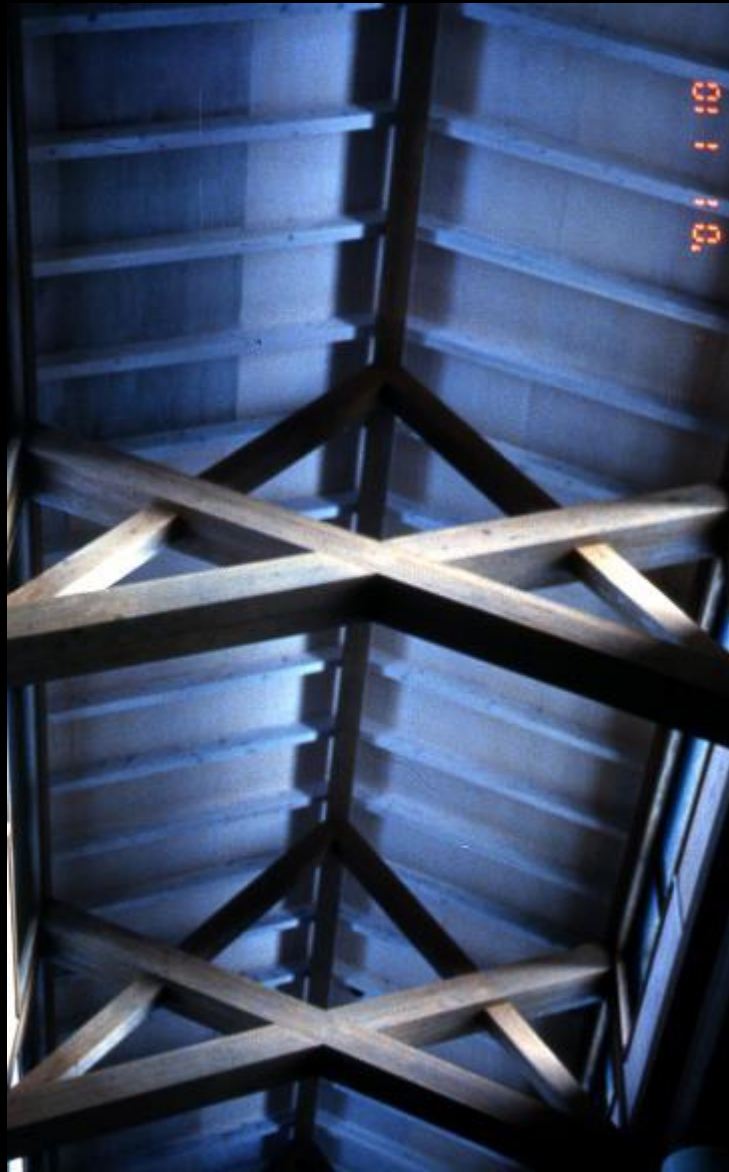
ボルトの無いすっきりとしたトラスの木組み
