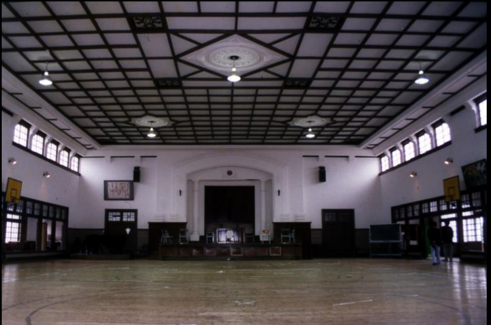
昭和10年竣工 神埼小学校講堂
