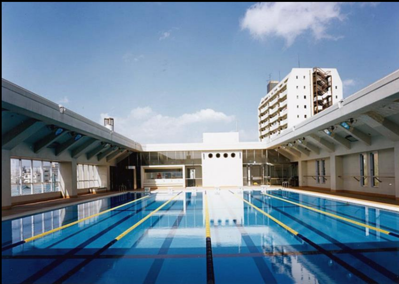
膜屋根架構前
