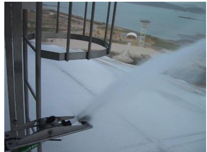
雨水散水による屋根面温度低下
