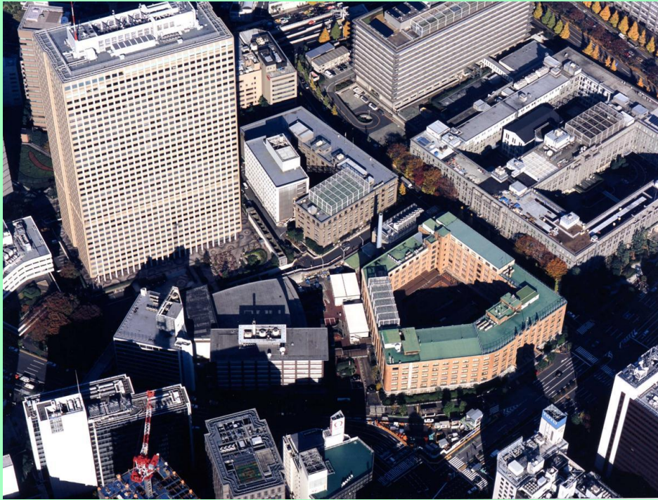
中央合同庁舎第7号館 2007年(一部1933年)
