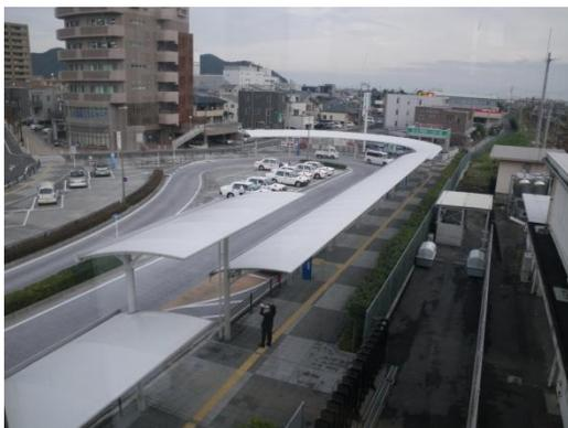
**次に**訪れた『島田駅北口・南口駅前広場 膜シェルター』は、平成19年から平成20年にかけて駅前広場の整備をする際、市長の意向もあり、数多の工法・材料から膜構造を選定されたとのことで、グレーの酸化チタン光触媒コーティングを施したB種膜材料を導入したバスやタクシー乗場の雨除けとしてのシェルターを、街路
