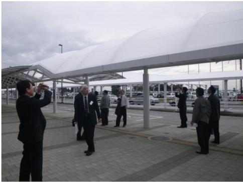
した県営空港で、総工費1900億円を掛けて総面積190haの敷地に2500mの滑走路を有する最後の地方空港とされています。ここで見学した施設は、駐車場の中央に位置する幅約30m長さ約50mの平面形の身障者用駐車場の膜シェルターと、バスとタクシーの車寄せ上部に長さそれぞれ約200mに及ぶ膜シェルター
