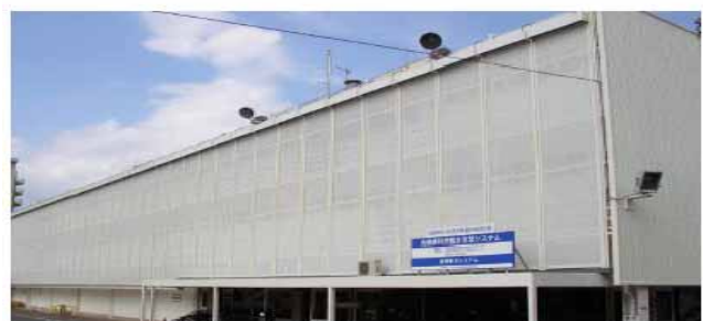
図2 冷却システムのフィールドテスト建物
