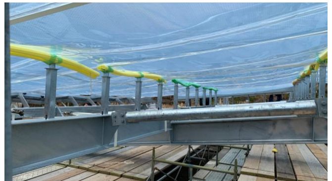
写真6 (a)：モックアップ写真（膜展張状況）
