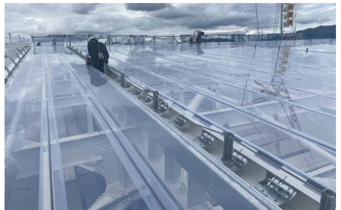
写真4：点検用ワイヤー兼避雷導体の設置
