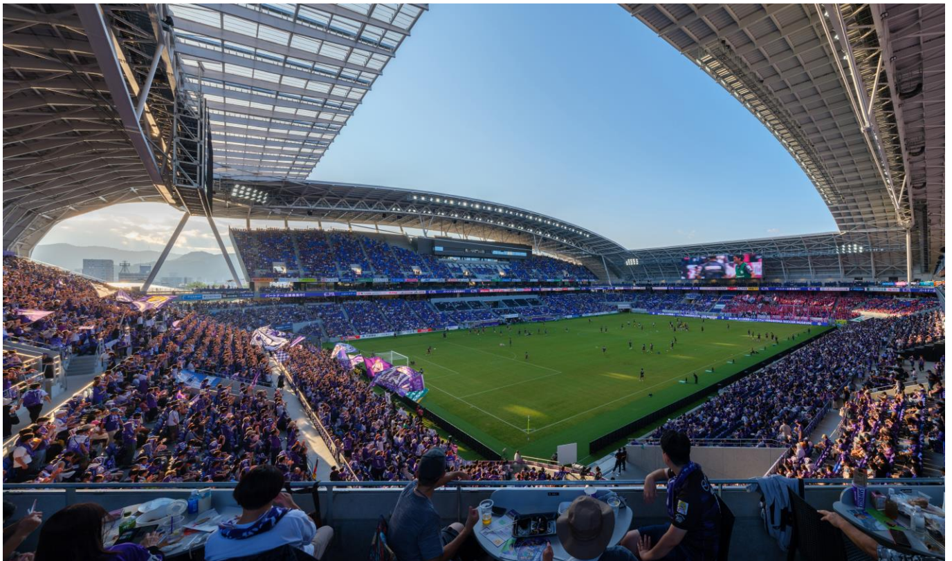
写真 8 (c) : 完工写真 (南東より) (写真提供 : ©大成 JV)
