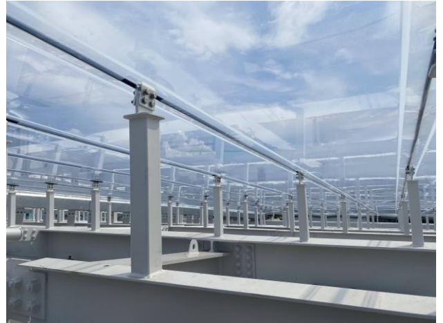
写真2：ケーブル中間、クランプ部
