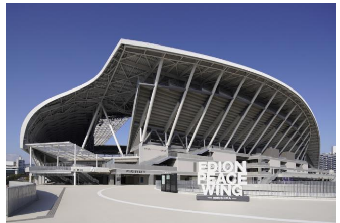
写真 8 (b) : 完工写真 (写真提供 : ©大成 JV)
