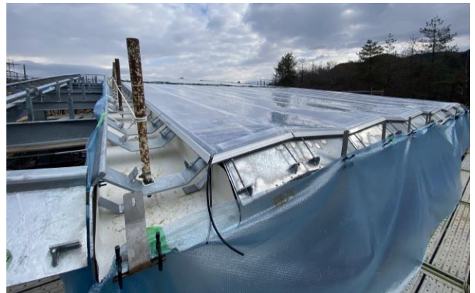
写真6 (b)：モックアップ写真（谷樋部分）
