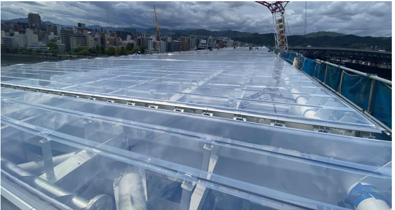
写真7 (a)：現場写真 膜定着完了時
