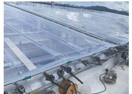
写真7 (d)：膜引込作業状況
