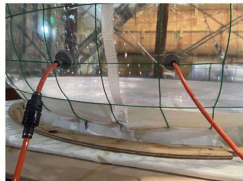
写真9 膜接合部の破断 および 送気口
