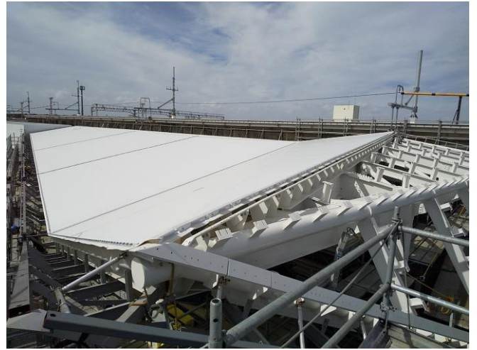
図 18 膜屋根の取付様子(駅本屋)
