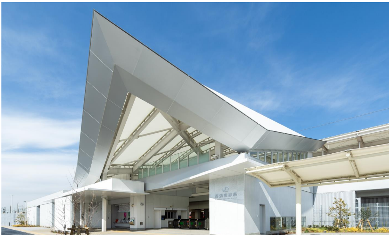
図 24 幕張豊砂駅の膜屋根の全景(出典：鉄建建設株式会社)
