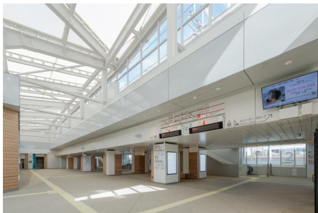
図 20 膜屋根の完成様子(駅本屋側のコンコース)
