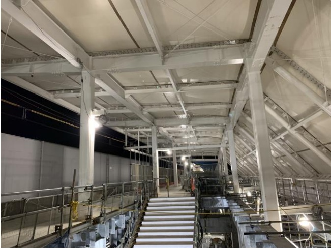
図 14 膜屋根の取付様子(ホーム上家)
