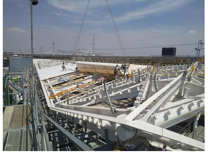
図 17 膜パネルの展張様子(駅本屋)
