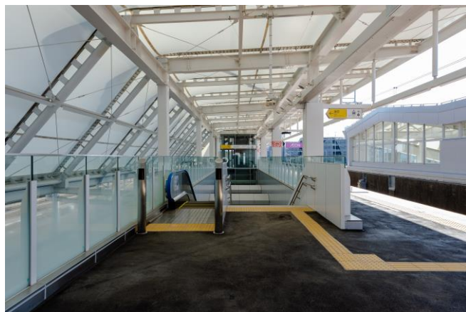
図 22 膜屋根の完成様子(ホーム上家、上り線側)
