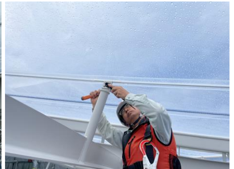
写真9 トルク確認状況
