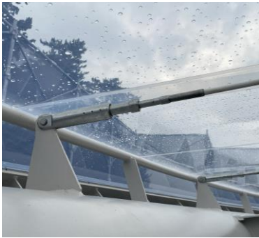
写真3 水下側ケーブル端部
