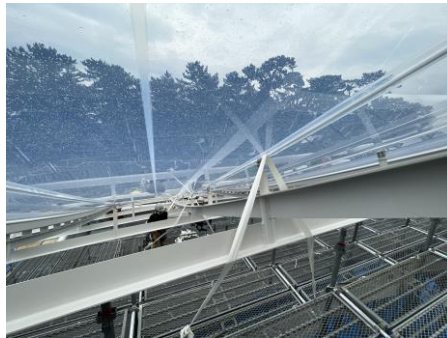
写真8 張力導入状況
