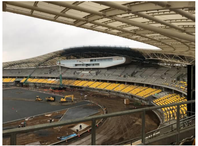
図 18 膜屋根の施工状況（全体エリア）
