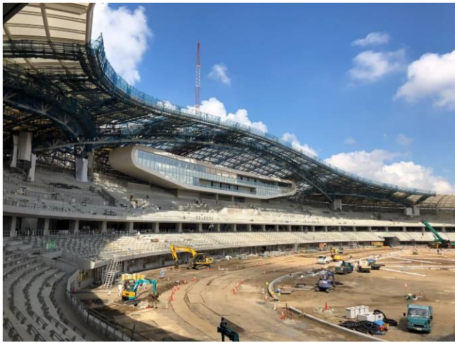
図 17 膜屋根の施工状況（アーチトラス側）
