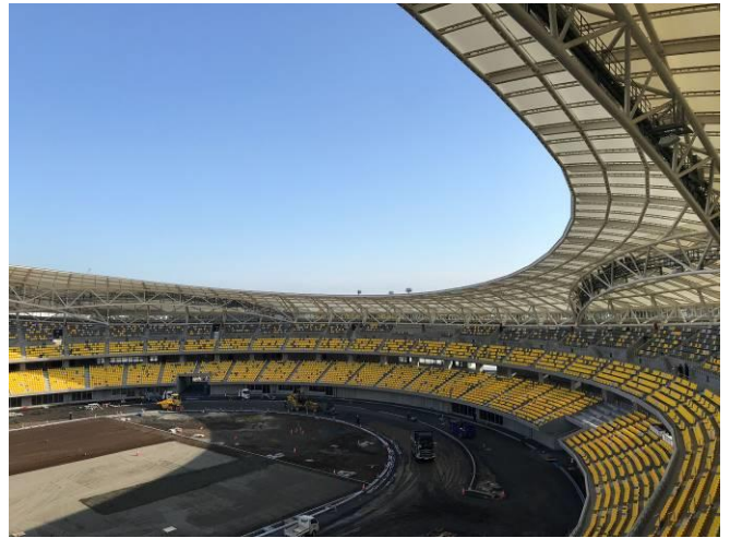
図 19 膜屋根の施工完了
