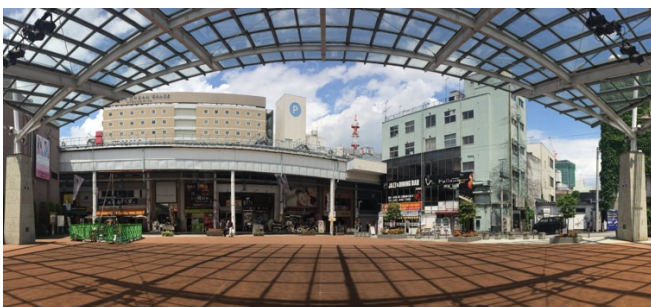
写真 2: 工事前のオリオンスクエア（ガラス屋根側から）
