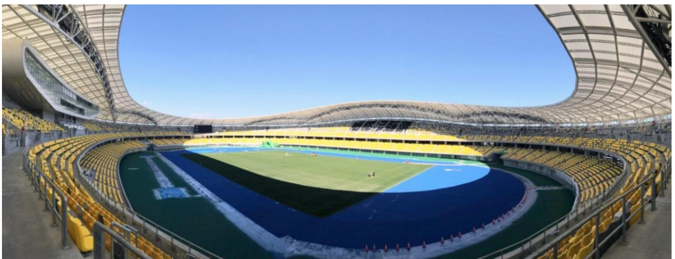
図 20 栃木新スタジアムの膜屋根の全景
