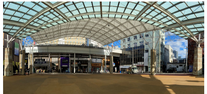
写真4: 工事後のオリオンスクエア (ガラス屋根側から)
