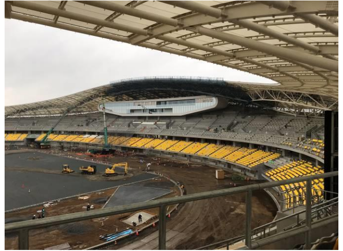
図 18 膜屋根の施工状況 (全体エリア)
