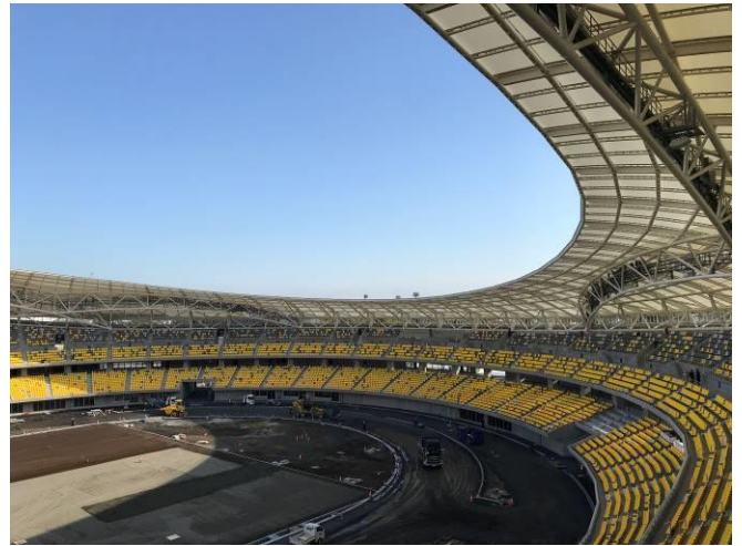
図 19 膜屋根の施工完了
