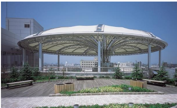
写真1 ドーム型独立上屋 (引用: 太陽工業株式会社ホームページ)
