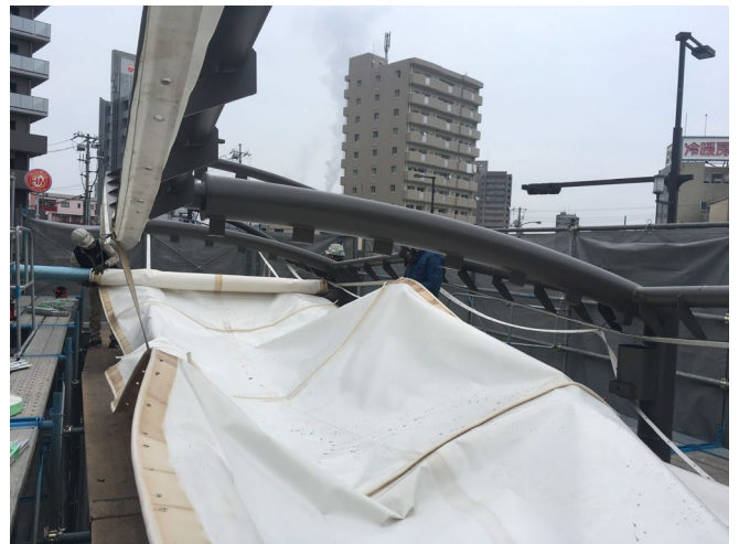
写真3 : 膜屋根 (下張り) の施工時
