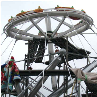
図3 施工時のS2材と上部リング
