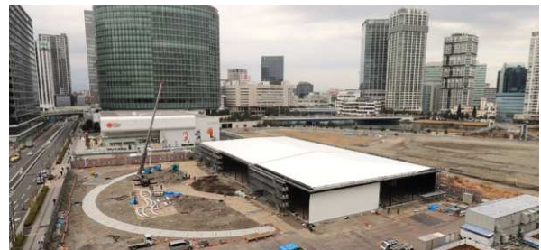
短期間で施工を進める鉄骨と膜屋根の様子
