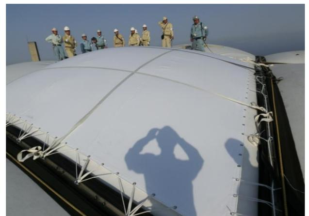
写真 7-2-10 応急処置膜の設置完了
