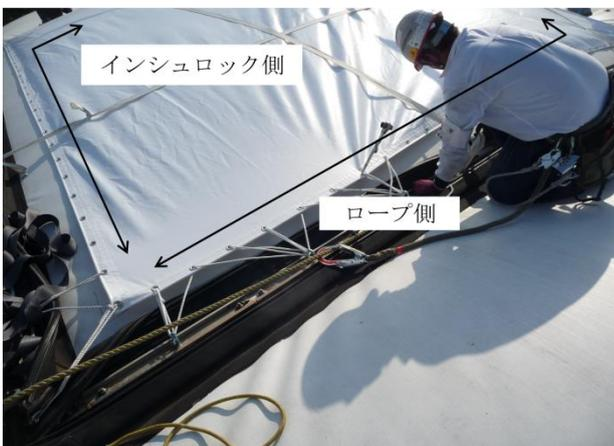
写真 7-2-7 膜定着作業（ロープと樹脂製結束バンド比較）
