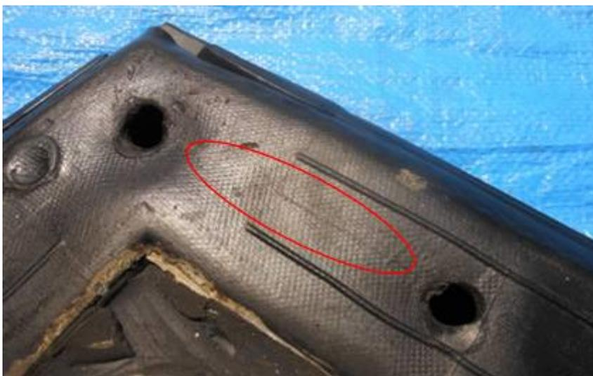
写真 5-4-1 頂部側交点周辺 F カバーゴム室内側サンプリング位置
