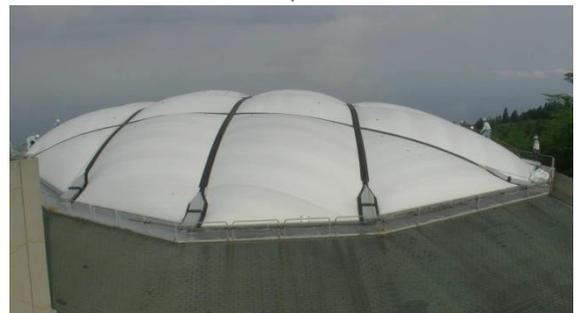
写真 8-2 デフレートから再インフレートに至る過程の形状
