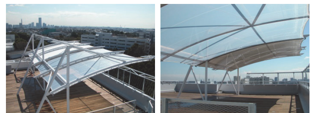
図 2 延伸成形による張力膜構造の実証実験
