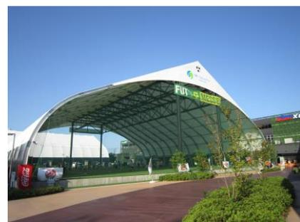
図1 妻面開放型膜構造建築物の例(フットサルコート)
