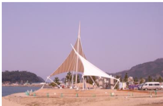
図 1-1 膜構造の HP 型独立上屋の建設例
