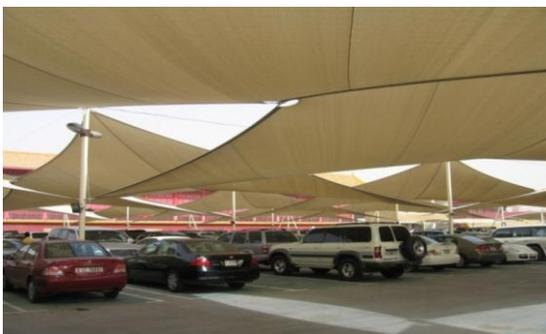
図1 メッシュ膜を用いた独立上屋の例
