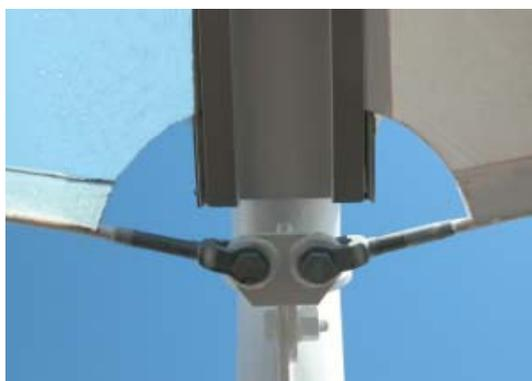
図 2 応力集中部のコーナー処理
