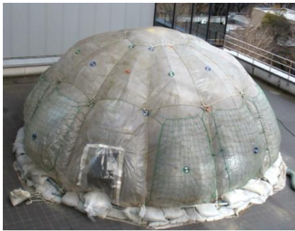
図16 完全インフレーションした正圧の空気膜構造 (気圧差約+110Pa)
