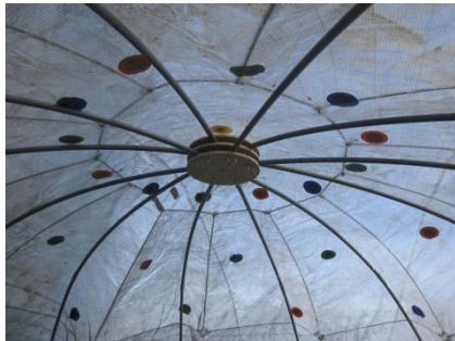
図17 骨組を入れた正圧の空気膜構造の内観 (気圧差約+110Pa)
