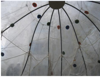
図 20(b) 補強された骨組みの座屈時の内観 (気圧差約70Pa)
