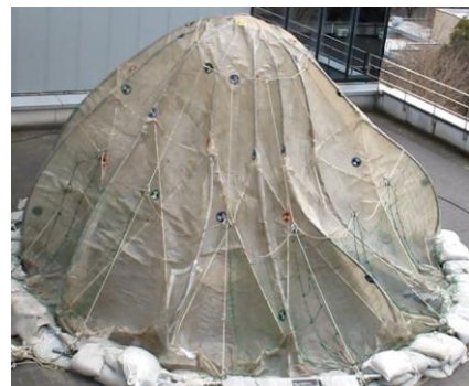
図20(a) 補強された骨組の座屈時の外観 (気圧差約-70Pa)
