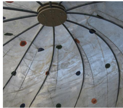
図18(b) 無補強の骨組の座屈時の内観 (気圧差約-50Pa)
