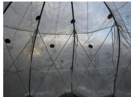
図19(b) 補強された負圧の空気膜構造の内観 (気圧差約-30Pa ~ 40Pa)
