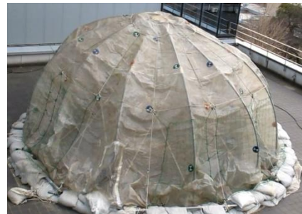
図19(a) 補強された負圧の空気膜構造の外観 (気圧差約-30Pa~40Pa)
