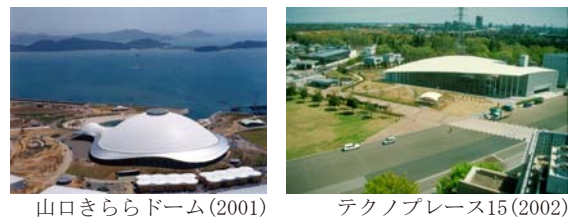
図3 ばねストラット式張力膜構造の事例(ガラス繊維膜使用)
