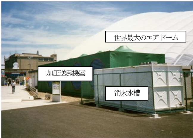
a) 加圧送風気室
