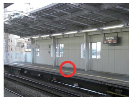
(c) M 駅金属屋根下
