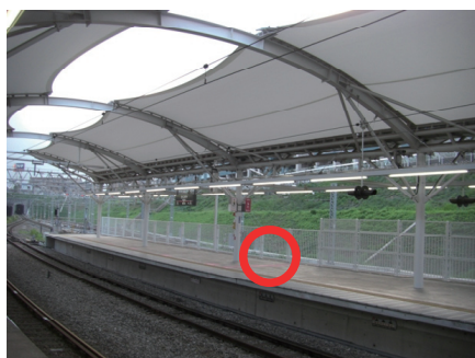
(a) K 駅膜屋根下
