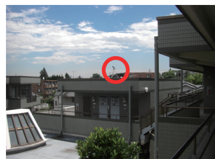
(f) T 棟屋上
