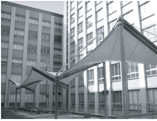
図7 イベントテラスの全景
