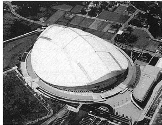
写真4 こまつドーム外観（屋根閉状態）
