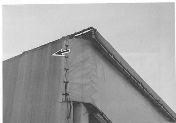
図一七 膜構造物の側面にみられる雨筋状汚れ（左）， 図一八 膜構造物の軒による雨筋状汚れ防止効果（但し、 底の効果により雨筋状汚れは観察されない（右） 中央部には軒がないために雨筋状汚れが発生している）
