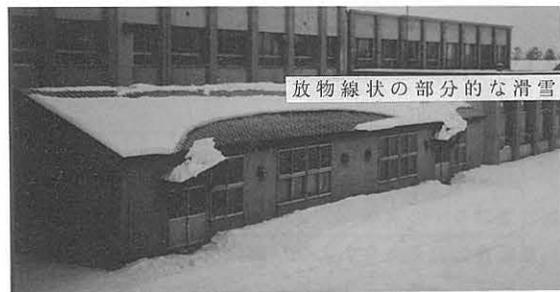
写真1 屋根上積雪の滑雪状態
