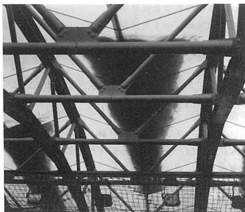
写真3 膜構造物における部分的な残雪現象
