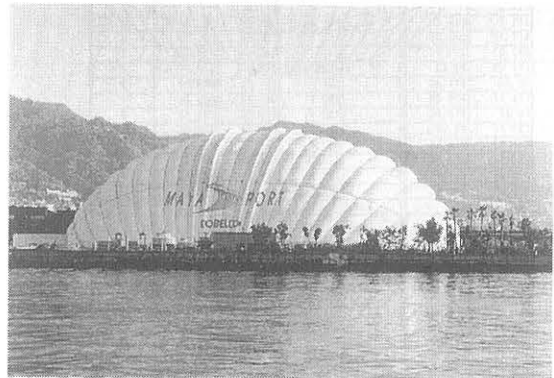
神戸アーバンスポーツドーム（めろんドーム）
