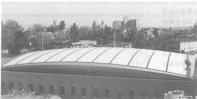
Photo. 2 実際に施工された体育館の骨組膜屋根の外観
